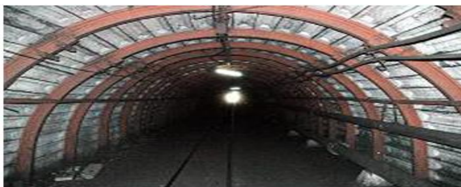
شکل ۲-۶- استفاده از قاب کشویی آرک برای نگهداری در تونل (ح، قاسم، ۱۳۹۵)
