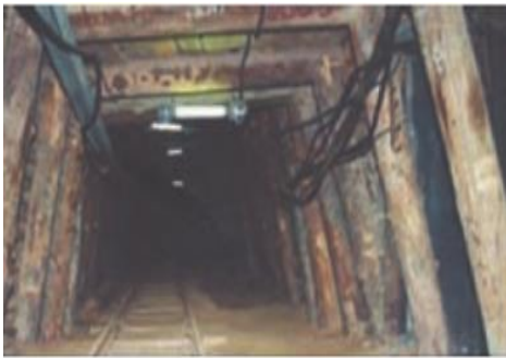
شکل ۳-۲- استفاده از نگهداری چوبی در تونل (ح، قاسم، ۱۳۹۵)
