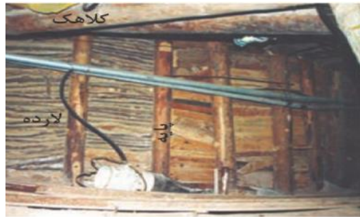
شکل ۳-۲- استفاده از نگهداری چوبی در تونل (ح، قاسم، ۱۳۹۵)
