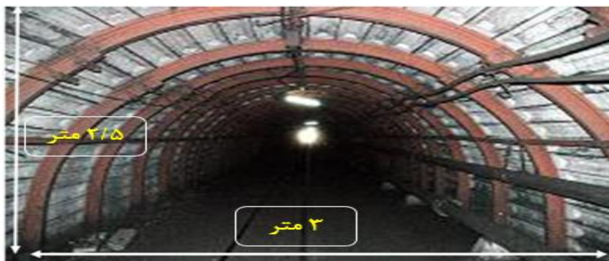
شکل ۳-۴- ابعاد تونل‌های بازکننده لایه K۸
