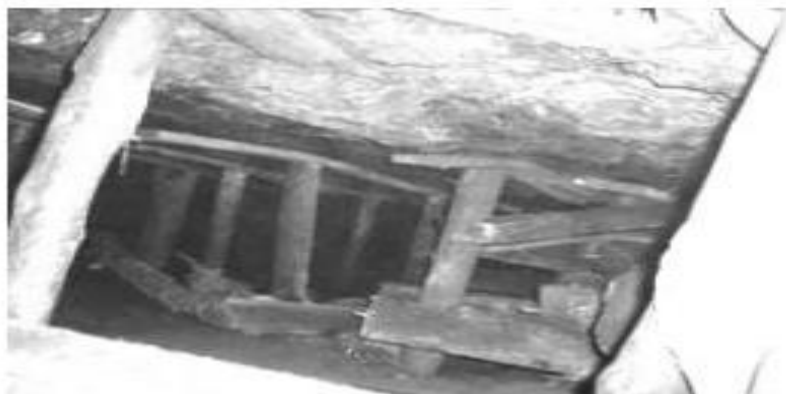
شکل ۸-۲- استفاده از پایه‌های چوبی جهت نگهداری سقف کارگاه
