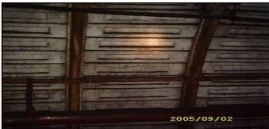
شکل ۷-۲- استفاده از لارده بتنی برای نگهداری از تونل (ج، قاسم، ۱۳۹۵)
