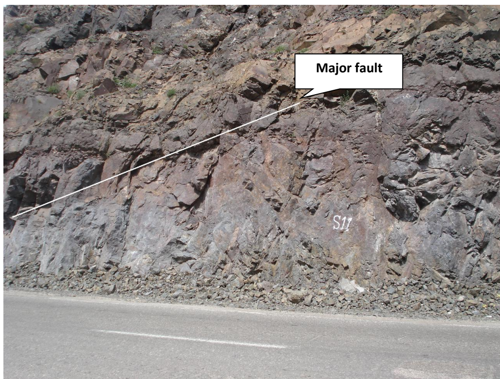
شکل ۵-۳- نمونه‌ای از گسل‌های اصلی بر روی شیب سنگی شماره ۱۱
