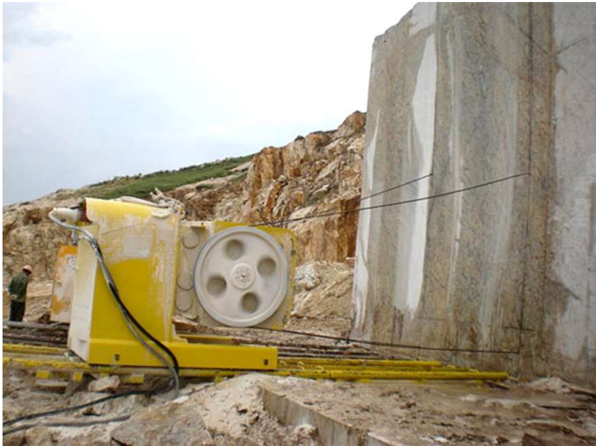
شکل ۲-۱: استخراج سنگ ساختمانی با سیم برش الماسه
