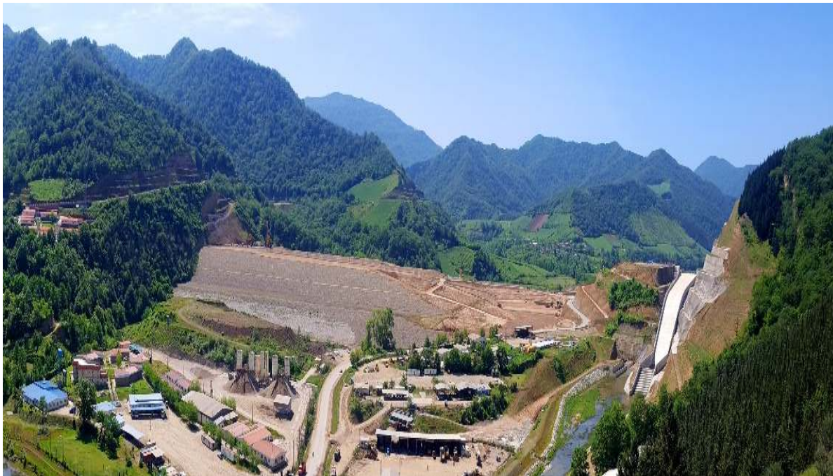
شکل ۴-۵ - نمایی از بخش اجرا شده‌ی سد نرماب [۴۶].
