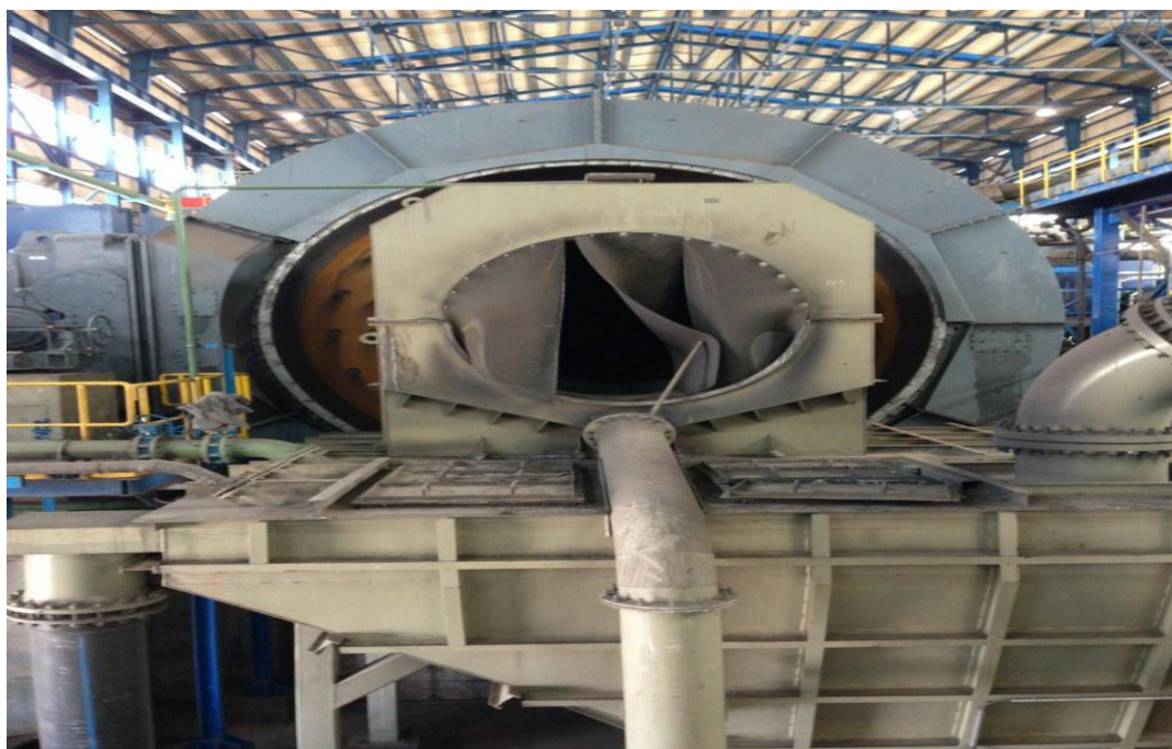
شکل ۱-۱۱: تصویر قسمت ترانیون خوراک آسیای گلوله‌ای
