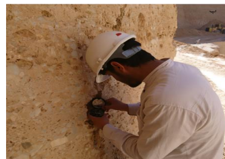
شکل ۵-۱: (الف) خط برداشت برای ناپیوستگی‌های موجود (ب) استفاده از کمپاس برای برداشت ناپیوستگی
