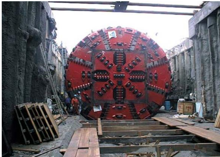
شکل ۴-۱: ماشین متعادل کننده فشار زمین جهت حفاری مترو پورتو با قطر ۸/۷ متر (Guglielmetti et al., 2008)
