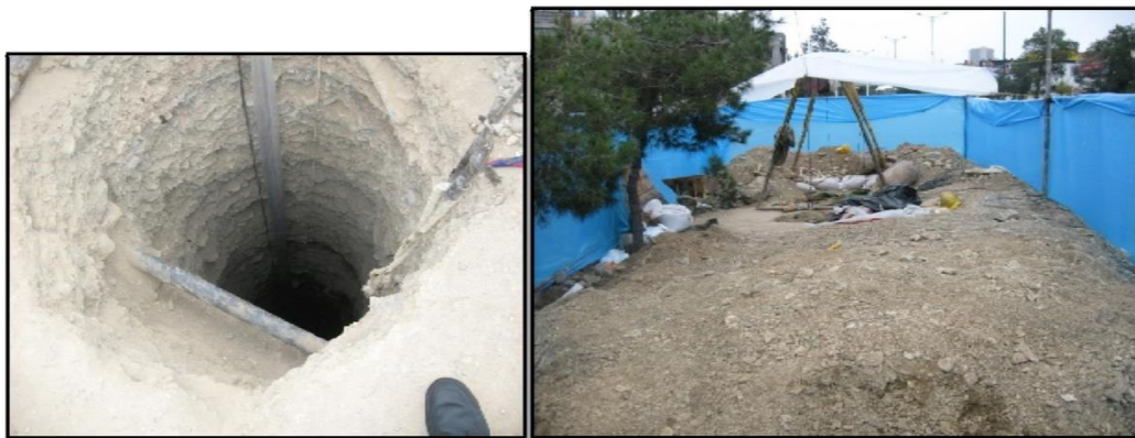
شکل ۴-۵: تصویر احداث یک حلقه چاه دستی در مسیر شمالی - جنوبی پروژه خط ۷ مترو تهران در محدوده بزرگراه شهید نواب صفوی (مهندسین مشاور ساحل، ۱۳۸۸).
