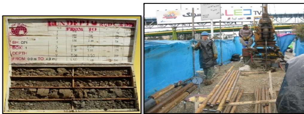
شکل ۵-۳: تصویر احداث یک حلقه گمانه‌ته‌ای و جعبه نمونه در مسیر شمالی - جنوبی پروژه خط ۷ مترو تهران در محدوده پل گیشا (مهندسین مشاور ساحل، ۱۳۸۸).
