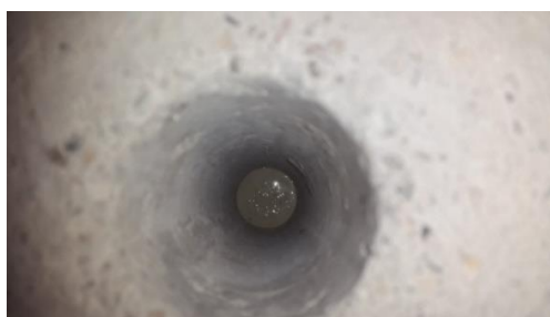
شکل ۶-۷- آب بندی انتهای گمانه بوسیله چسب سنگ
