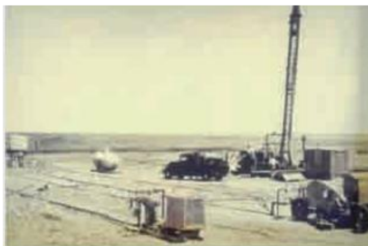
شکل ۱-۲- اولین تجربه Hydrofrac در سال ۱۹۴۷ در میدان گازی هوگوتن در گرانت کانتی، کانزاس (Montgomery et al., 2010)
