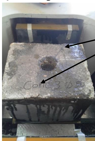
شکل ۶-۱۳- ترک ایجاد شده در نمونه بتنی
