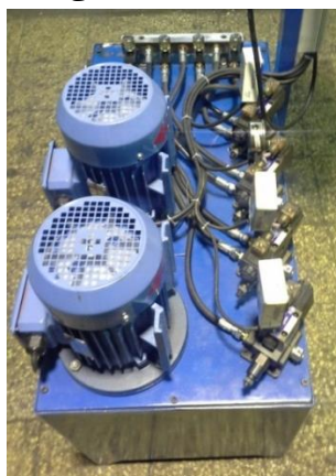
شکل ۵-۲۲- واحد هیدرولیک پس از نصب شلنگ‌های فشار بالا برای هدایت سیال
