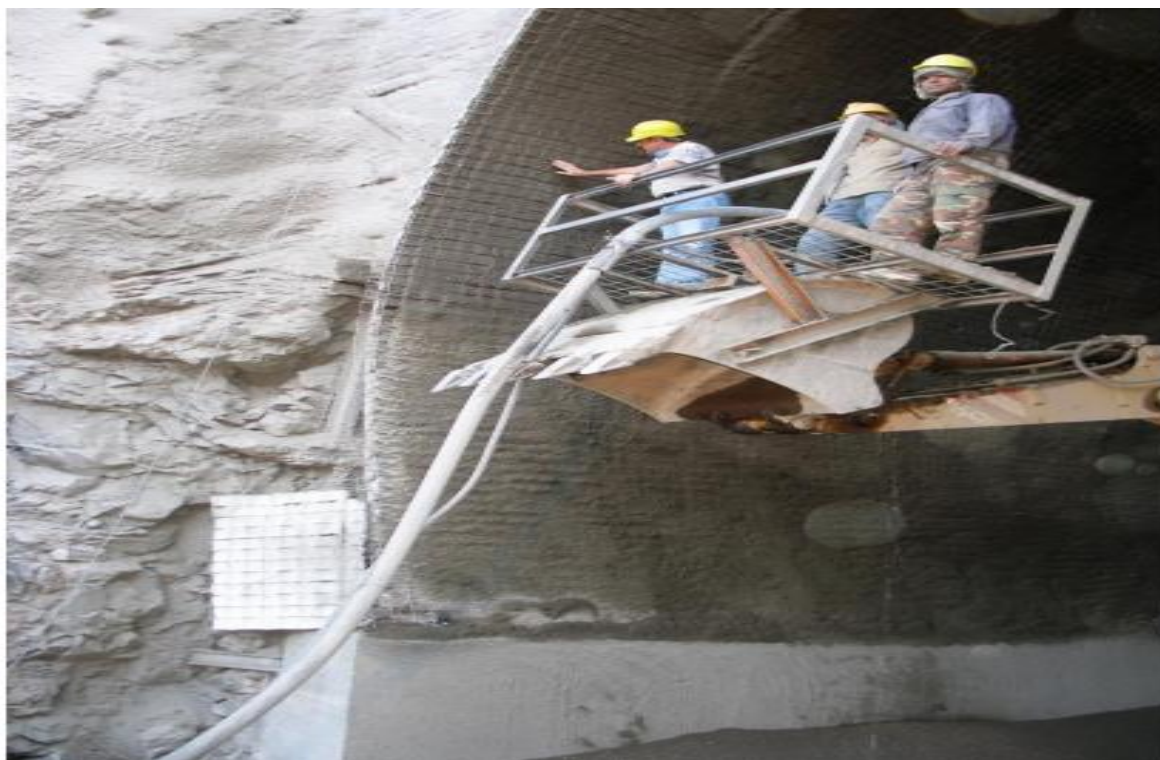
شکل ۳-۷- بررسی نصب پانل در تونل های راه آهن اصفهان شیراز
