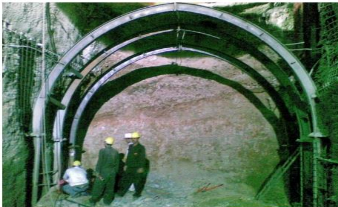
شکل ۲-۵- پرتال ورودی کارگاه L۳ مترو تهران - تقاطع فاطمی ولیعصر
