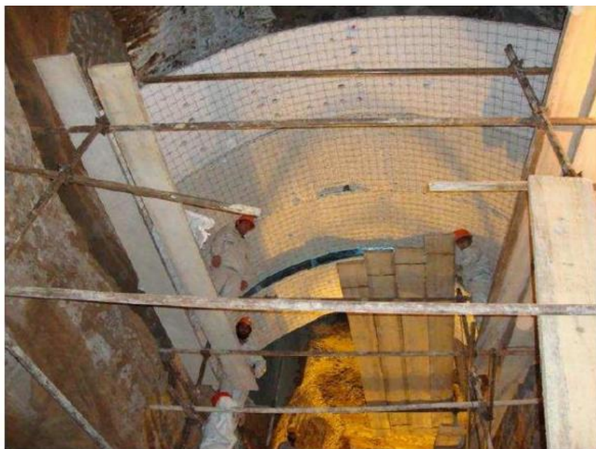
شکل ۳-۵- نصب پانل سه بعدی در راه ترانزیت شمال غرب ع محور ماکو
