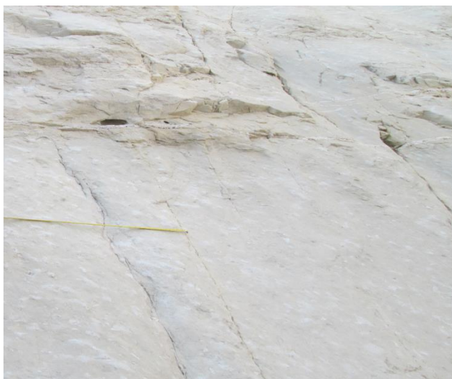
شکل ۴-۵- نمایی از متر نواری جهت اندازه‌گیری فاصله‌داری درزه‌های ساختمانه سد کارون ۴
