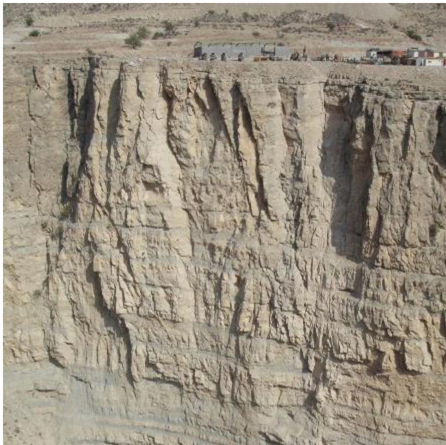
شکل (۵-۳): واحد میشان میانی و ناحیه انتقال در سد (گزارش زمین شناسی مهندسی، ۱۳۹۱)
