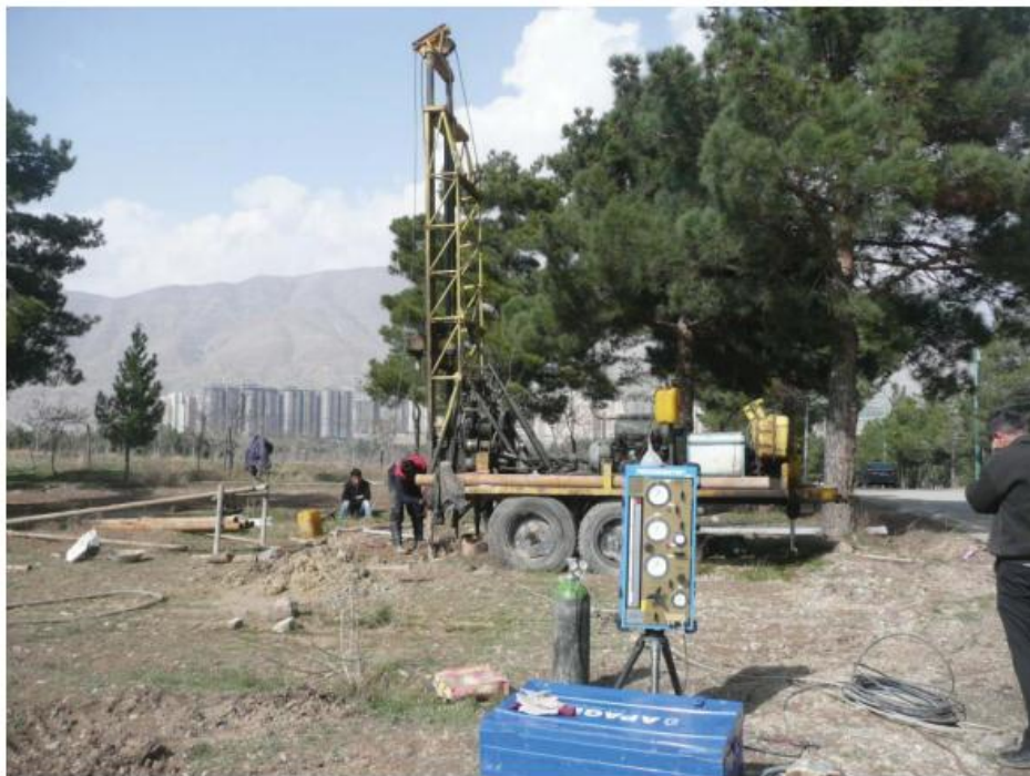
شکل ۳-۶- حفاری گمانه توسط ماشین DBH [۲].
