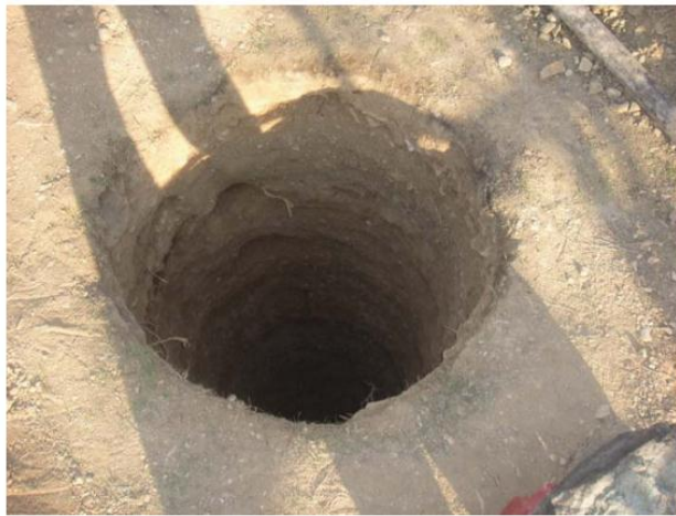
شکل ۳-۵- چاهک دستی حفاری شده [۲].
