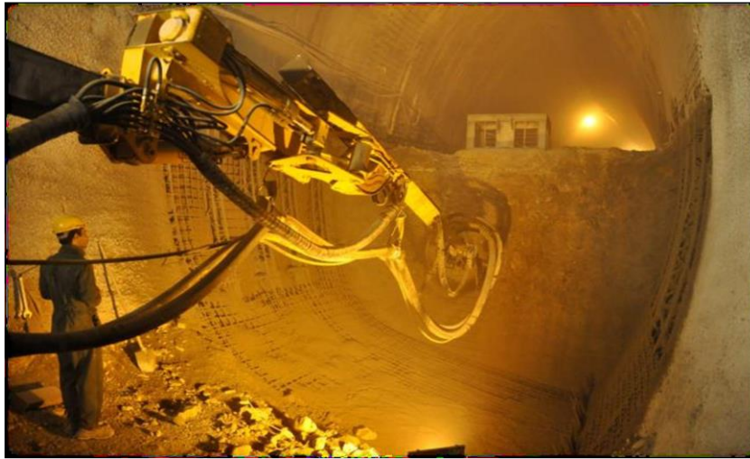
شکل ۱-۲: عملیات اجرای شاتکریت به همراه قاب مشبک در تونل حکیم (موسسه حرا، ۱۳۹۲)
