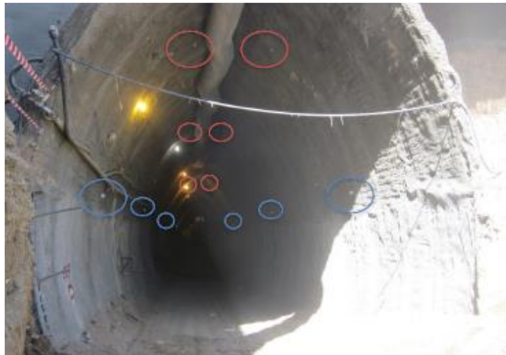
شکل ۵-۲: نصب پین های ژئودتیک در یکی از گالری های تونل حکیم (موسسه حرا، ۱۳۹۲)
