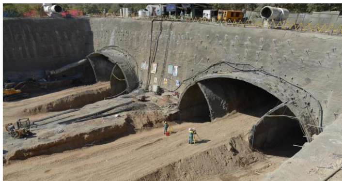
شکل ۴-۷: ترتیب مراحل مختلف حفاری تونل حکیم (موسسه حرا، ۱۳۹۲)
