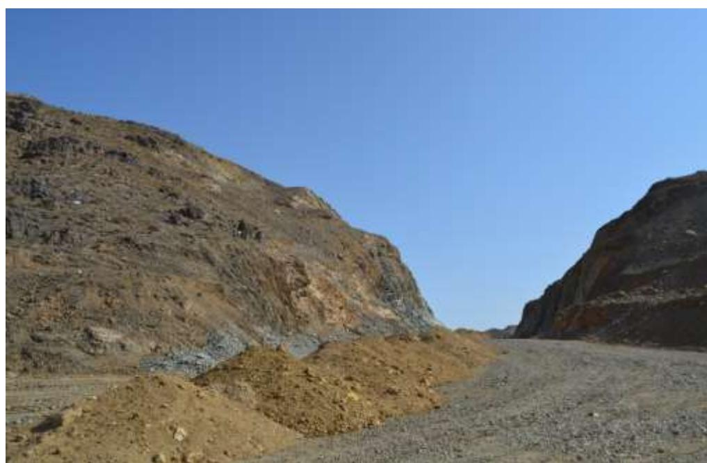
شکل(۶-۴) نمایی از ریزش خطرناک دیواره مسیر معدن CN به معدن دردوى (ترانشه دوبل)
