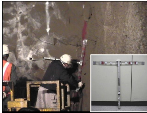
شکل ۴-۳۰- استفاده از خط کش T شکل در جانمایی چال‌های انفجاری (Kim&Moon, 2013)
