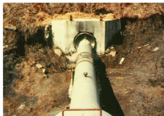
شکل ۳-۴: تزریق آب به دیوی باطله با روش تزریق مستقیم و اسپری آب (Chaiken & Bayles, 1988)
