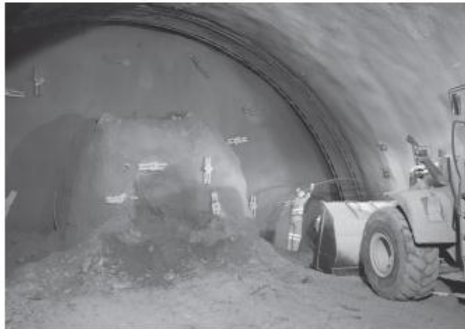
شکل ۳-۱۳ وصل کردن میله‌های نگهداری سینه کار در طول ساخت تونل لاینزر ۱ LT31 در وینا اتریش (Chapaman, D.N., et al, 2010)
