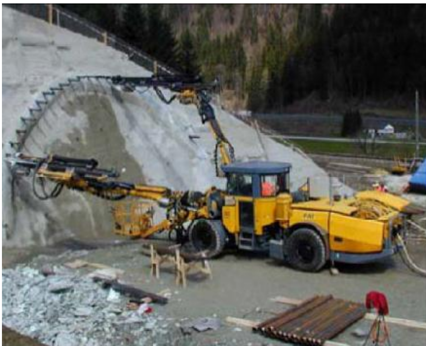
شکل ۳-۱۶ نصب لوله‌های پیش تحکیم در روش حفر لوله جداری با استفاده از جامبو دریل (Volkman, G.M., et al, 2008)
