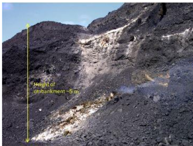
شکل ۲-۱۵: باطله کربن دار در معرض خودسوزی شدید. با وجود سوختن شدید، نشانه کمی در بالای سطح انباشت گاه وجود دارد (Glenn et al., 2015)
