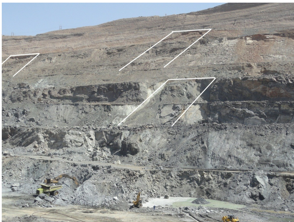
شکل ۷-۱۶: ریزش‌های رخ داده در مقطع ۱۰۲۰۰۰
