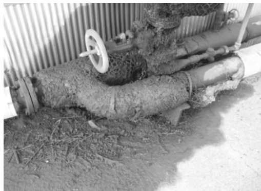
شکل (۵-۱۵): نشت نفت نزدیک کف تانک (Idemitsu engineering Ltd, 2003).
