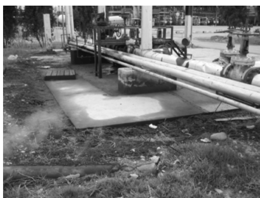
شکل (۵-۱۴): نشت نفت از جریان‌سنج‌ها ۱ و شیرهای کنترل (Idemitsu engineering Ltd, 2003).
