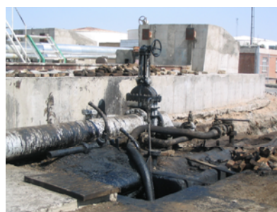
شکل (۵-۲۰): موقعیت‌های نشت نفت (نقطه ۳) (Fusione Techno Solutions Co., 2006).
