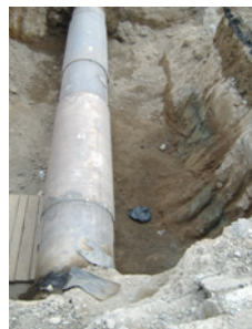
شکل (۵-۱۸): موقعیت‌های نشت نفت (نقطه ۱) (Fusione Techno Solutions Co., 2006).
