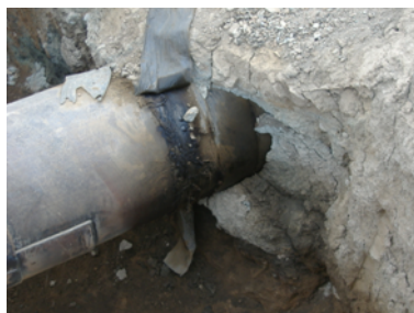
شکل (۵-۱۸): موقعیت‌های نشت نفت (نقطه ۱) (Fusione Techno Solutions Co., 2006).
