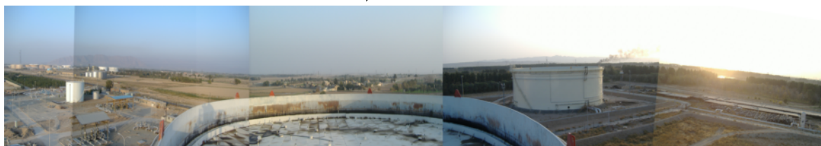
شکل (۵-۲۳): موقعیت نشت نفت در اطراف یک خط لوله زیرزمینی در ایستگاه پمپاژ (Fusione Techno Solutions Co., 2006).
