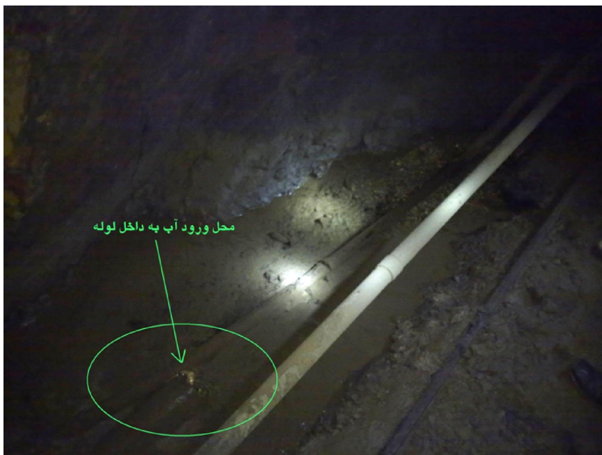
شکل ۳-۴- محل ورود آب به داخل لوله
