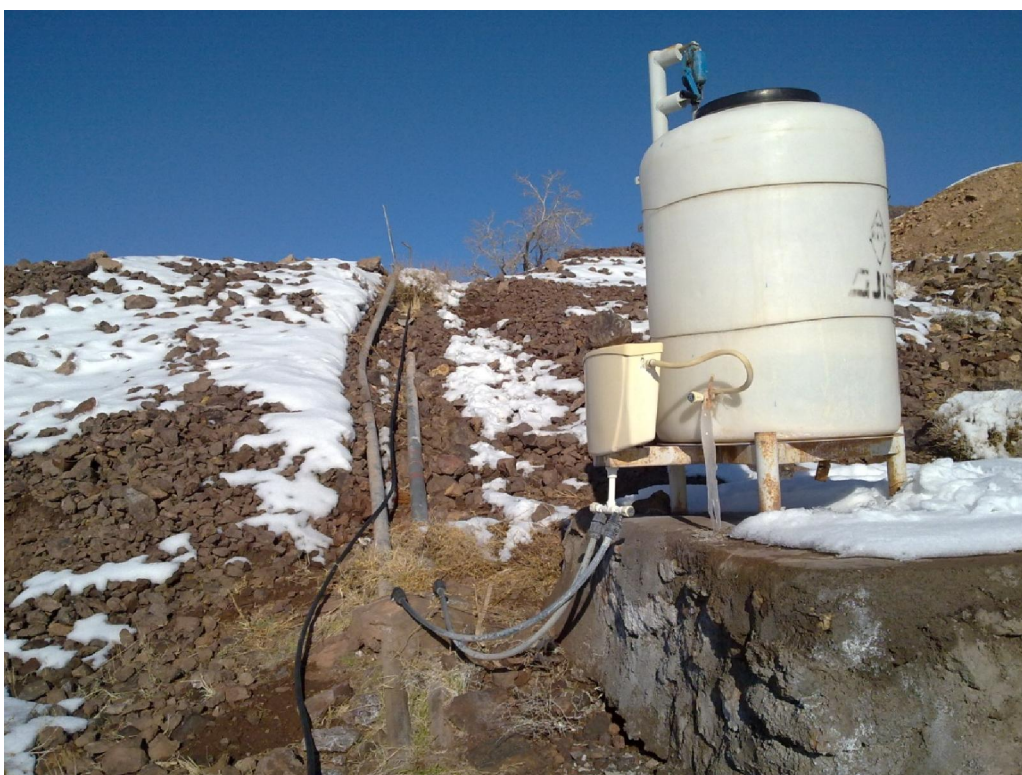
شکل ۴-۵- دستگاه کلرزنی، مابین تونل معدن و روستا
