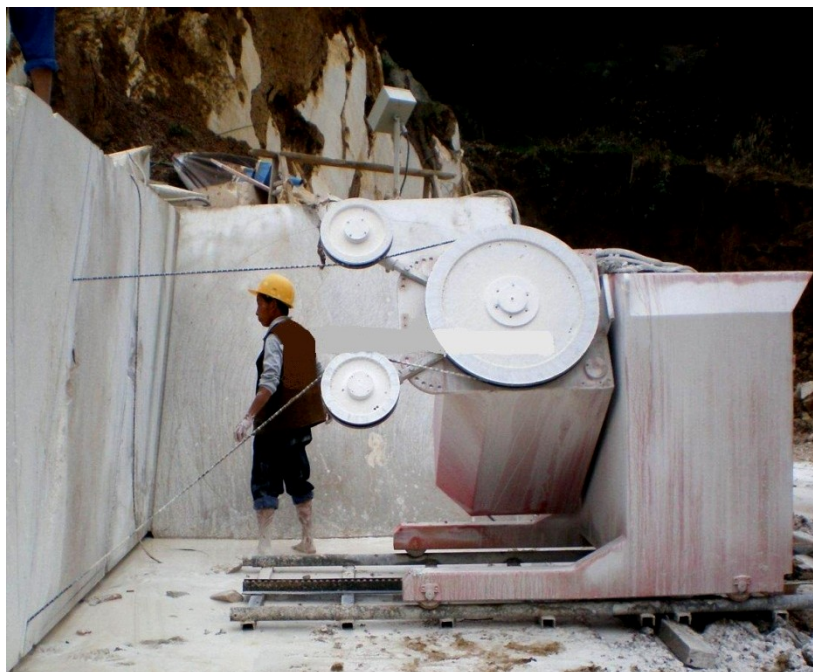
شکل ۱-۲: استخراج بلوک سنگی توسط سیم برش الماسه (STONEBTB, 2010)
