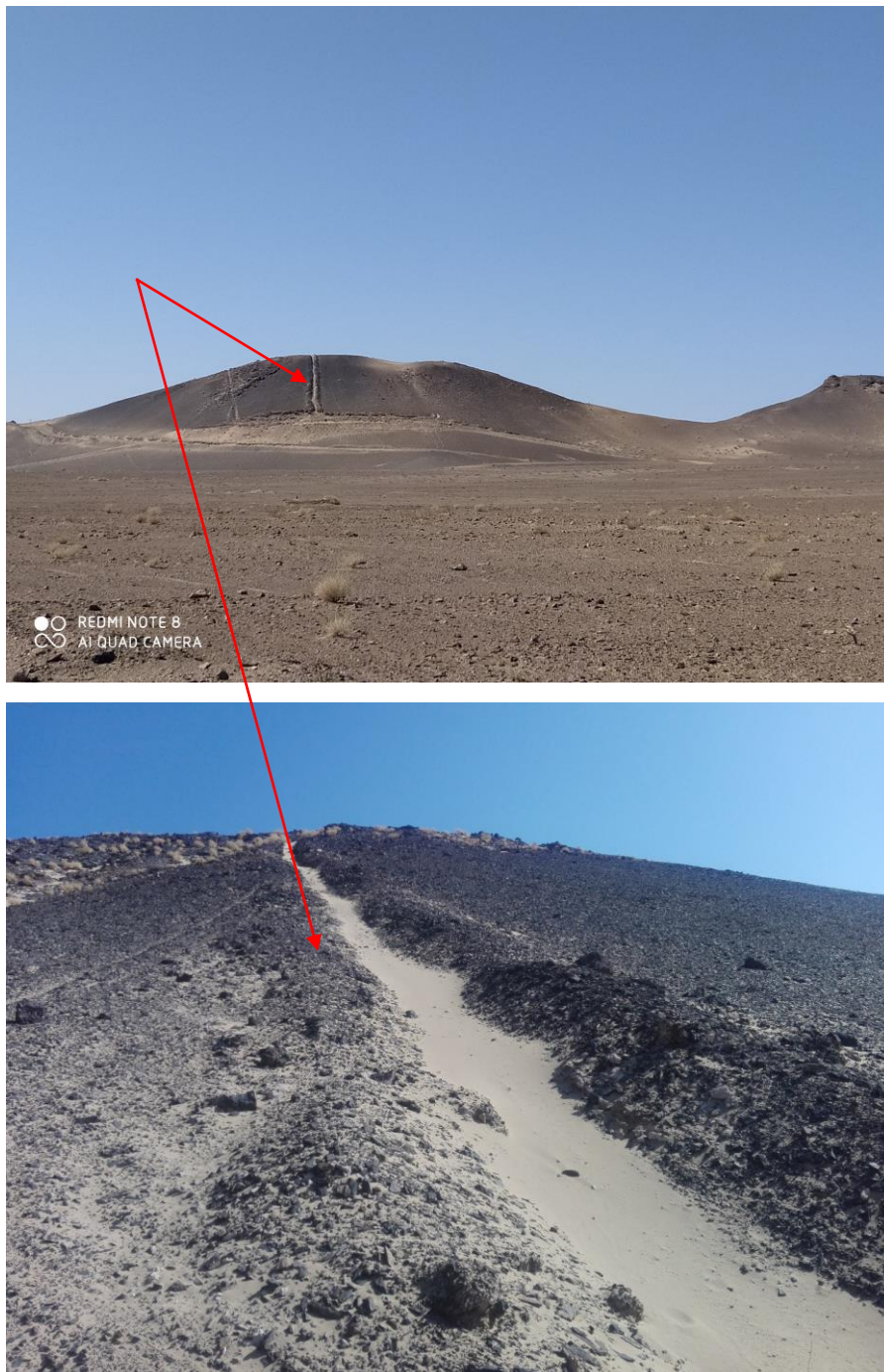
شکل (۵-۱۲) حفر ترانشه بر روی کوه حاوی مگنتیت در جنوب محدوده
