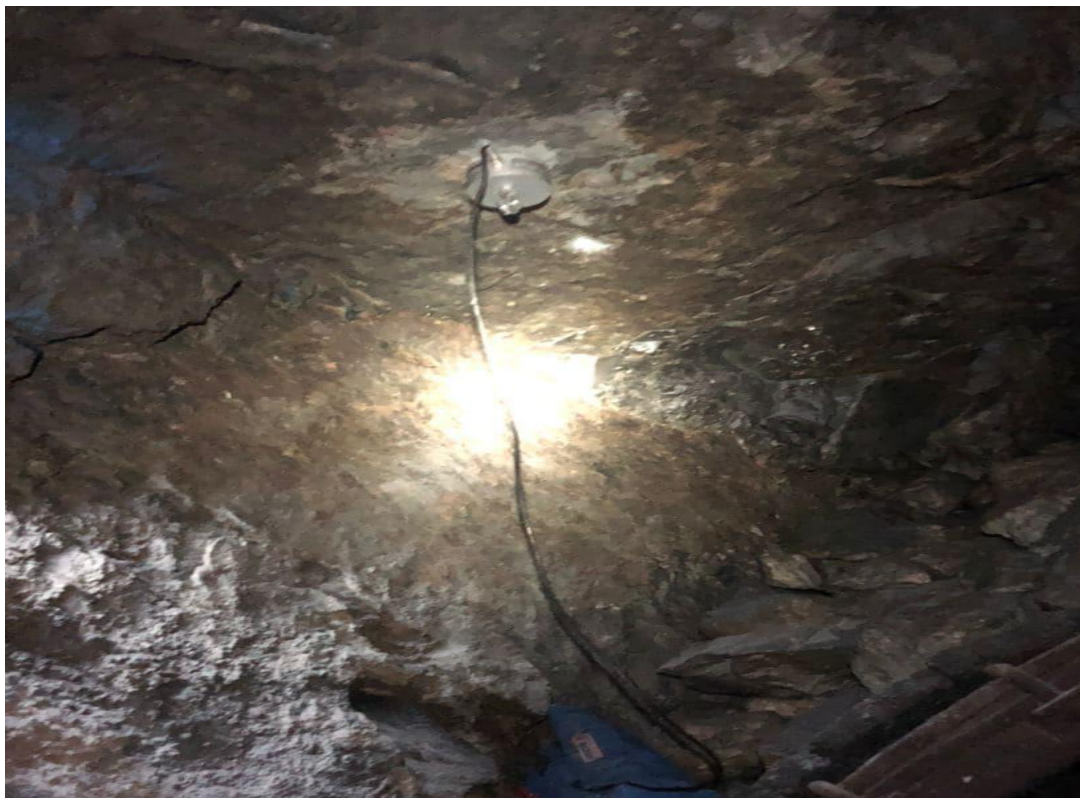
شکل ۴-۱۴: محل نصب دستگاه ژئوفون نسبت در تونل
