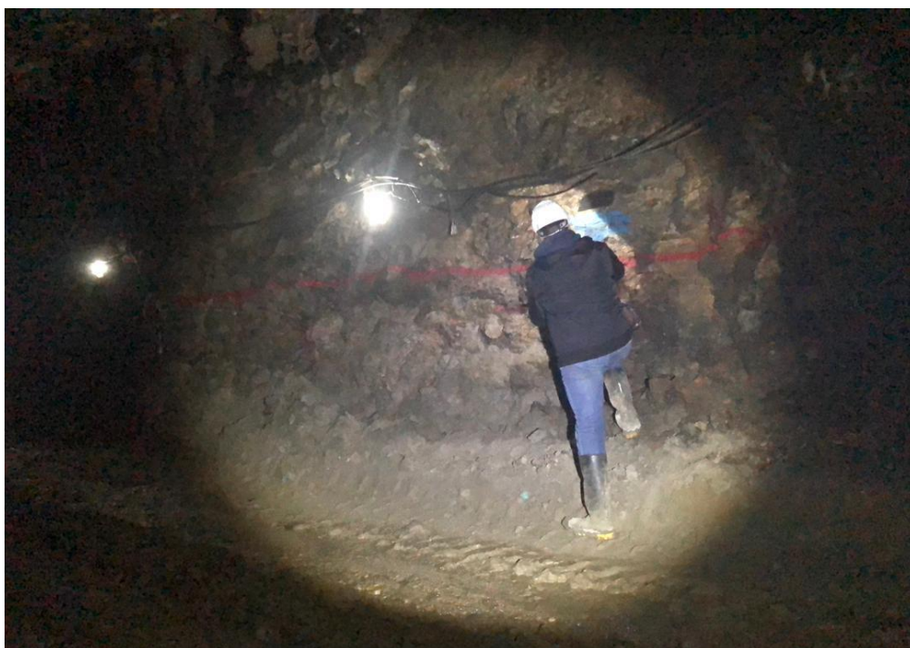
شکل ۴-۹: خط برداشت درزه برداری در معدن انگوران
