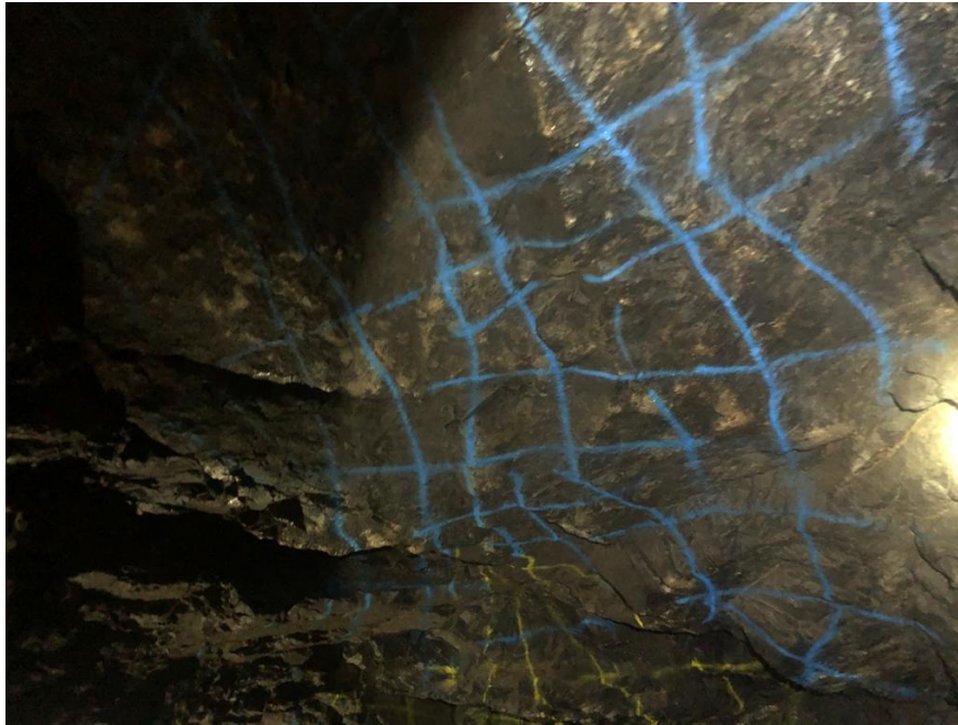
شکل ۴-۱۵: نمایی از شبکه ترسیم شده برای مشاهده ریزش‌های احتمالی
