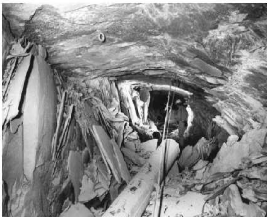
شکل ۲-۳- فلس‌های نازک و بلند حاصل از ترک خوردگی کششی در عمق ۲۶۰۰ متر در کوارتزیت [5].
