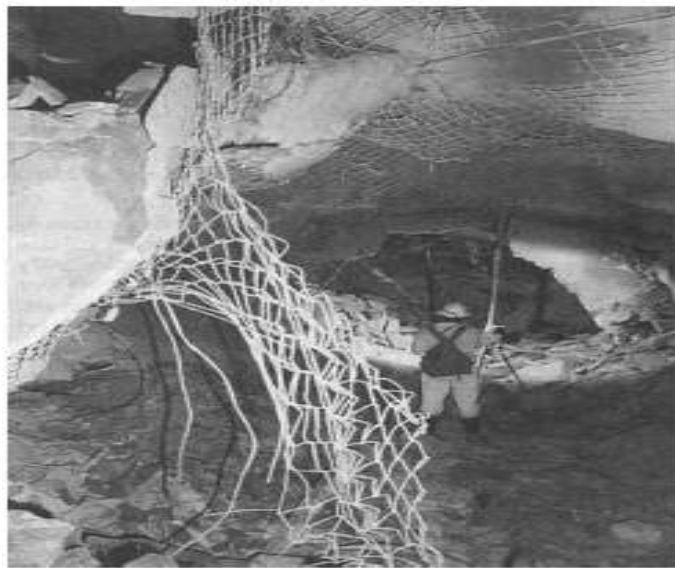
شکل ۲-۱۳- خرد شدن سینه کار تونل در فاصله ۴۰ متر [7]
