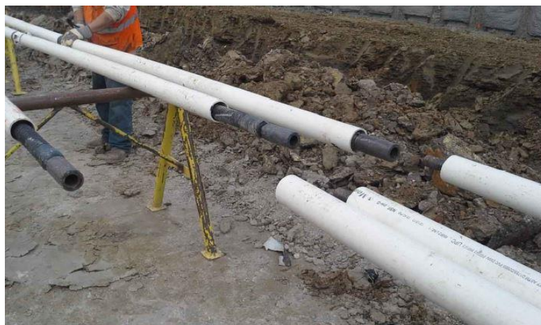
شکل ۳-۲۵: نحوه اتصال مکانیکی دو میله برای افزایش طول تاندون (Arrizabalaga,2014).
