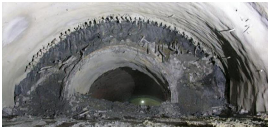
شکل ۲-۵: اضافه حفاری تونل پیشرو پلاتامون در مرز جنوبی تونل (Marinos & Tsiambaos, 2010).
