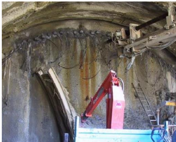
شکل ۳-۱۵: تزریق لوله‌های فورپولینگ پس از نصب (Volkman et al, 2008).
