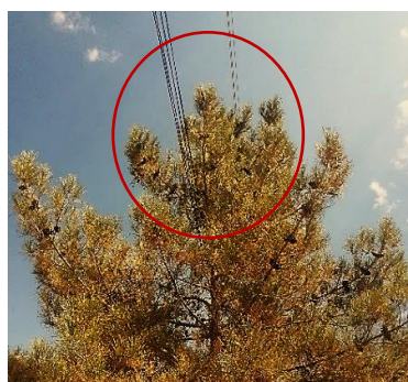
شکل (۱-۲): وقوع خطای امپدانس بالا در اثر برخورد سیم هادی به درخت
