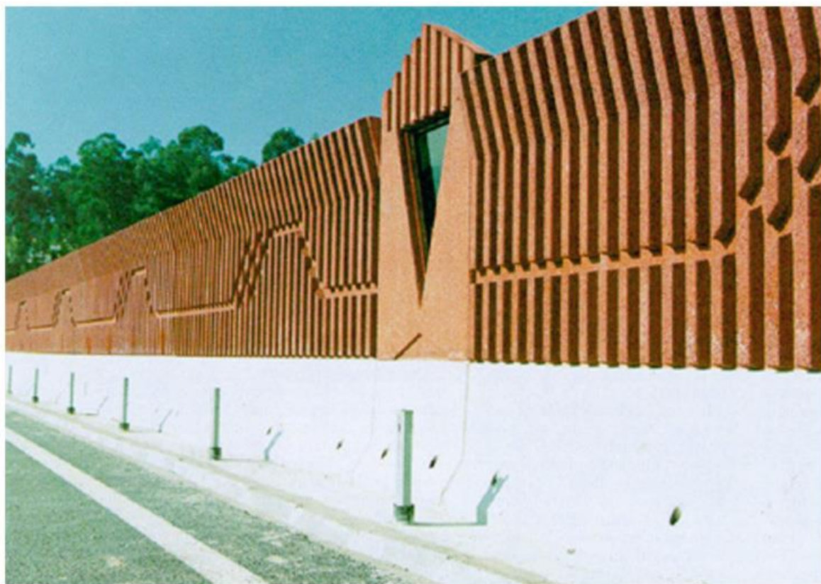
شکل (۲-۱) دیوار جاذب صوتی که در یکی از بزرگراه های کشور پرتغال بنا شده است. [۳]
