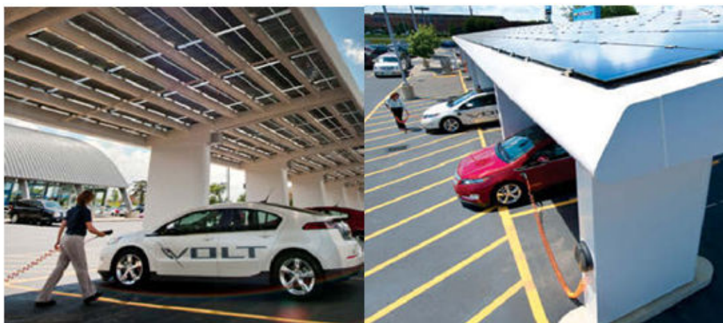
شکل ۲-۱۰ جایگاه سوخت خودروهای هیبریدی با استفاده از ماژول فتوولتائیک
