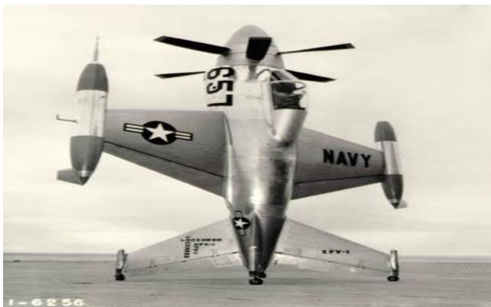
شکل (۱-۱) نمونه اولیه هواپیمای عمودپرواز XFV-1
