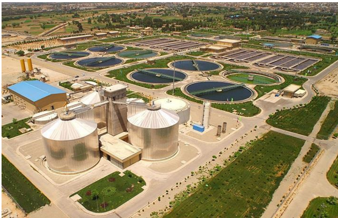
شکل (۲-۳) نمای دوم از تصفیه‌خانه فاضلاب جنوب تهران
