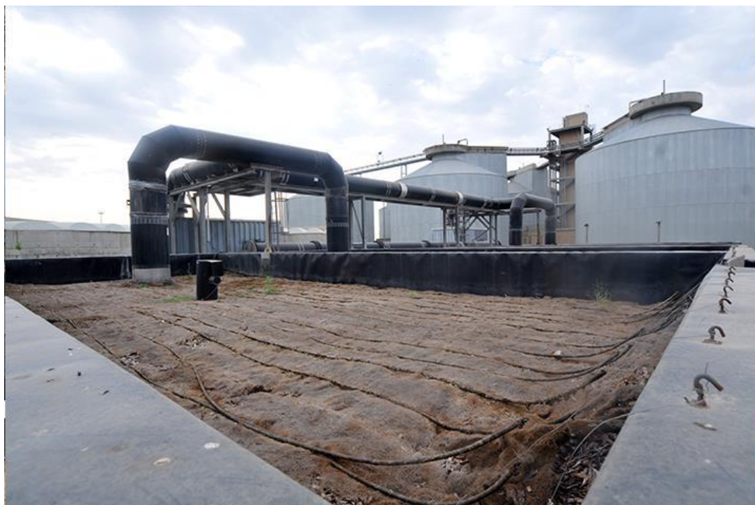
شکل (۳-۳) فرایند آبگیری در تصفیه‌خانه فاضلاب جنوب تهران
