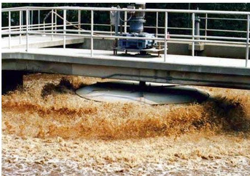
شکل (۹-۱) فرآیند لجن فعال با هوادهی از بالا
