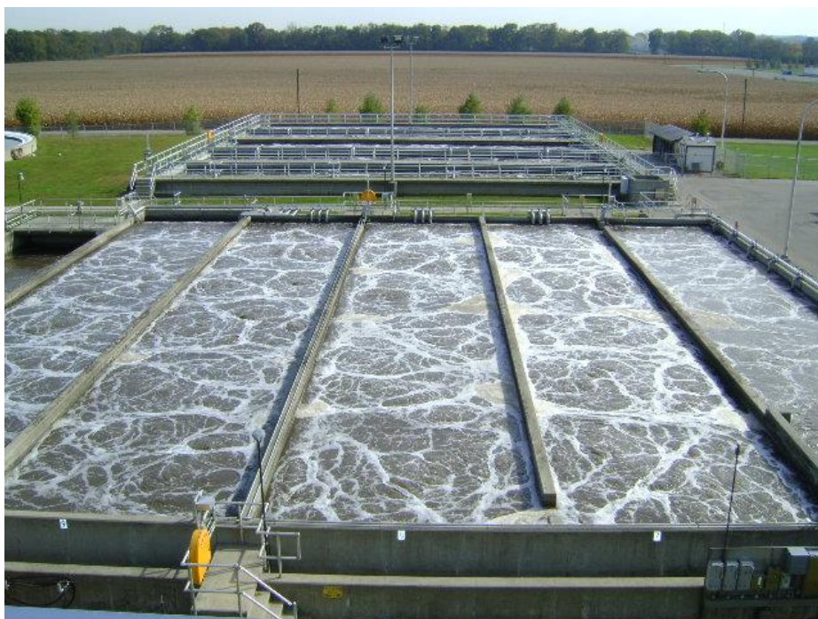
شکل (۱۰-۱) فرآیند لجن فعال با هوادهی از کف
