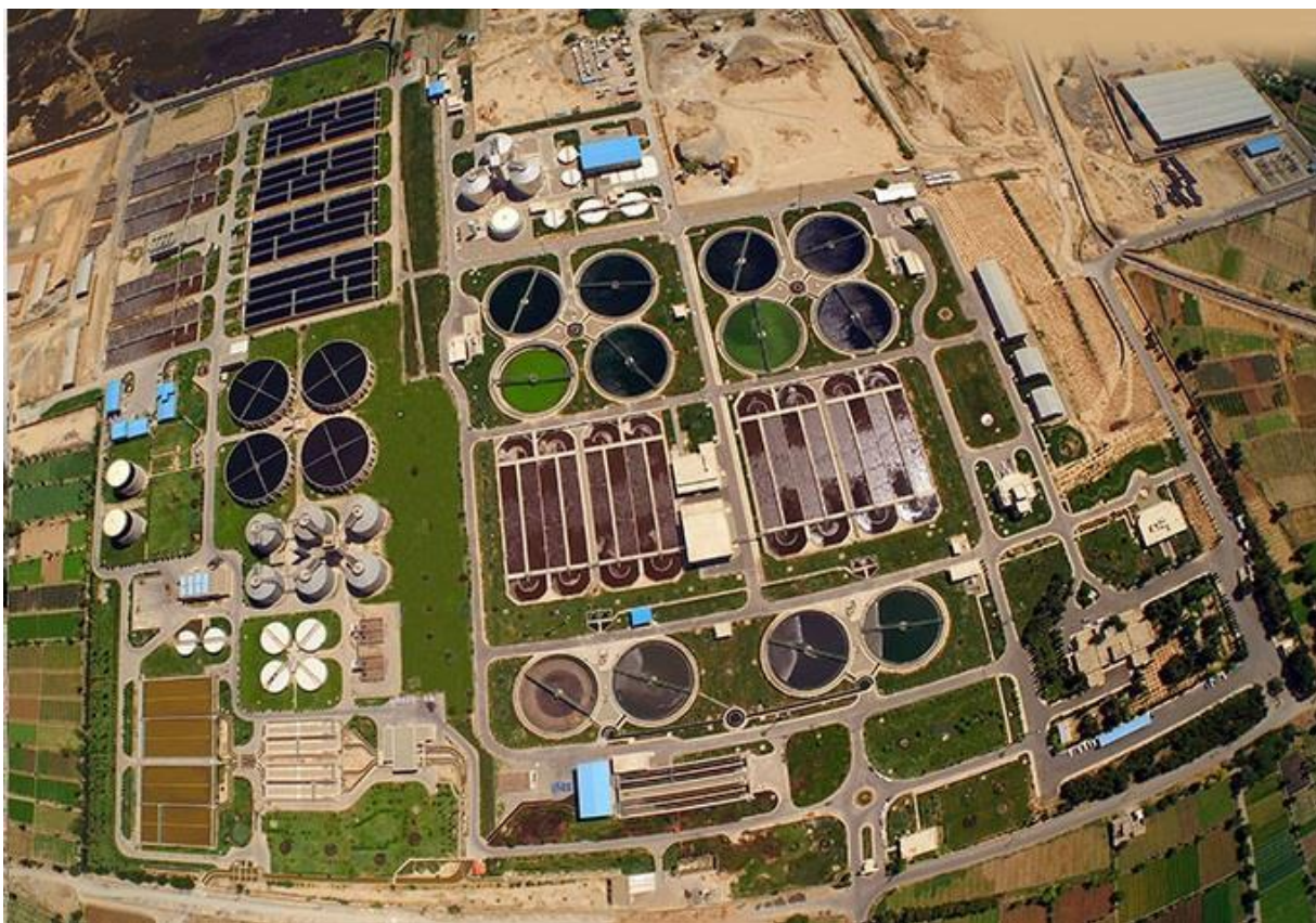
شکل (۱-۳) نمای اول از تصفیه‌خانه فاضلاب جنوب تهران
