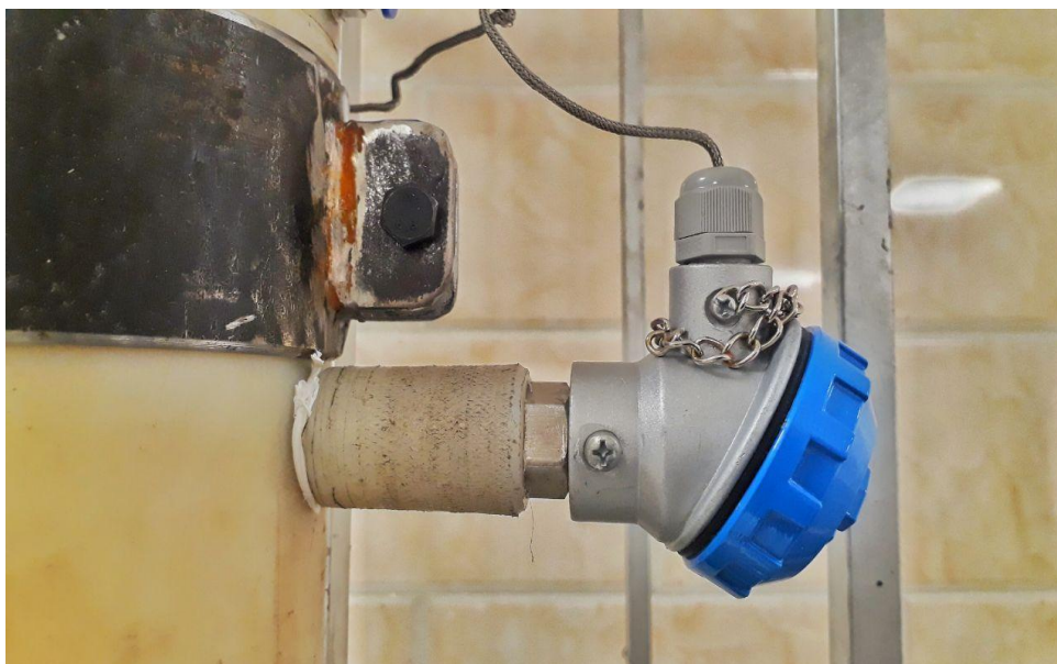
شکل ۳-۸: سنسور اندازه‌گیری دمای آب از نوع PT 100 پراب دار
