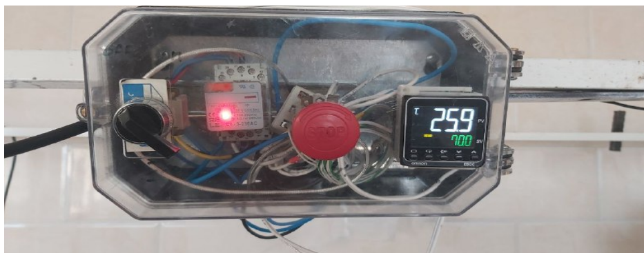
شکل ۳-۱۲: کنترل کننده دمای سیال ساخت شرکت EMRON
