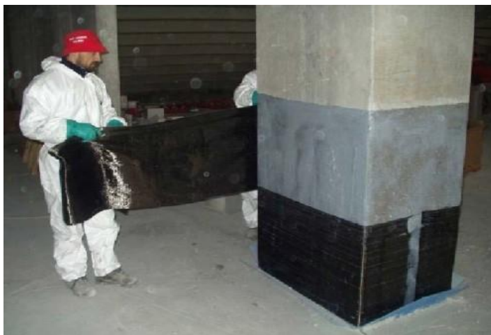
شکل (۸-۱) دورپیچ کردن با FRP
