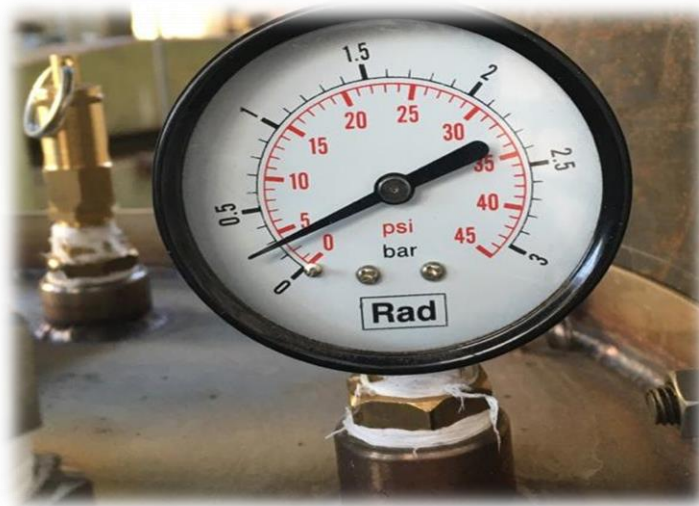
شکل ۴-۵ گیج فشار و شیر اطمینان
