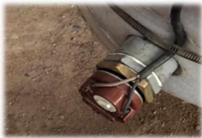
شکل ۴-۷ ترموستات و المنت حرارتی جهت کنترل دمای آب
