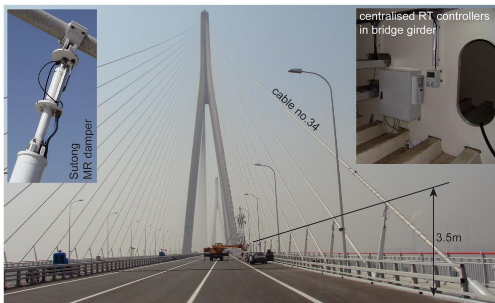
شکل ۹-۱- کاربرد میراگر مگنتورئولوژیکال در کنترل ارتعاشات پل سیتانگ ۱ در چین [۳۰].
