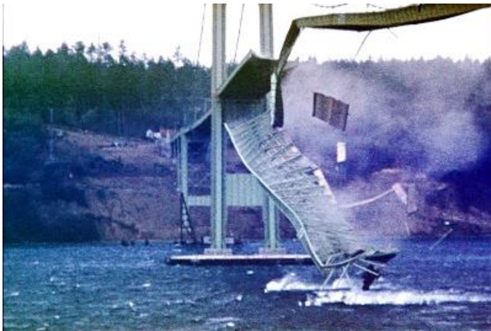
شکل ۱-۳: عکس از تخریب پل تاکوما در ۱۹۴۰ توسط ارتعاشات ناشی از گردابه‌ها [۱]
