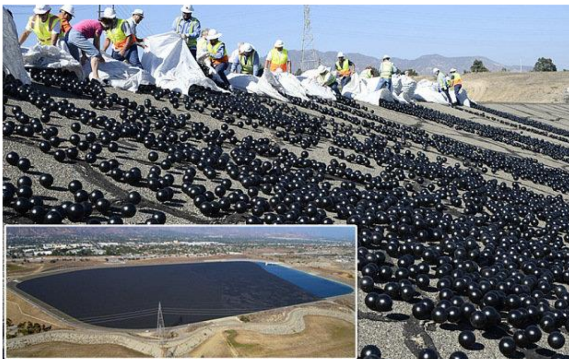
شکل ۱-۴: استفاده از توپ‌های پلاستیکی سیاه‌رنگ جهت پوشش‌دهی سطح آب سد لس‌آنجلس آمریکا [۹].
