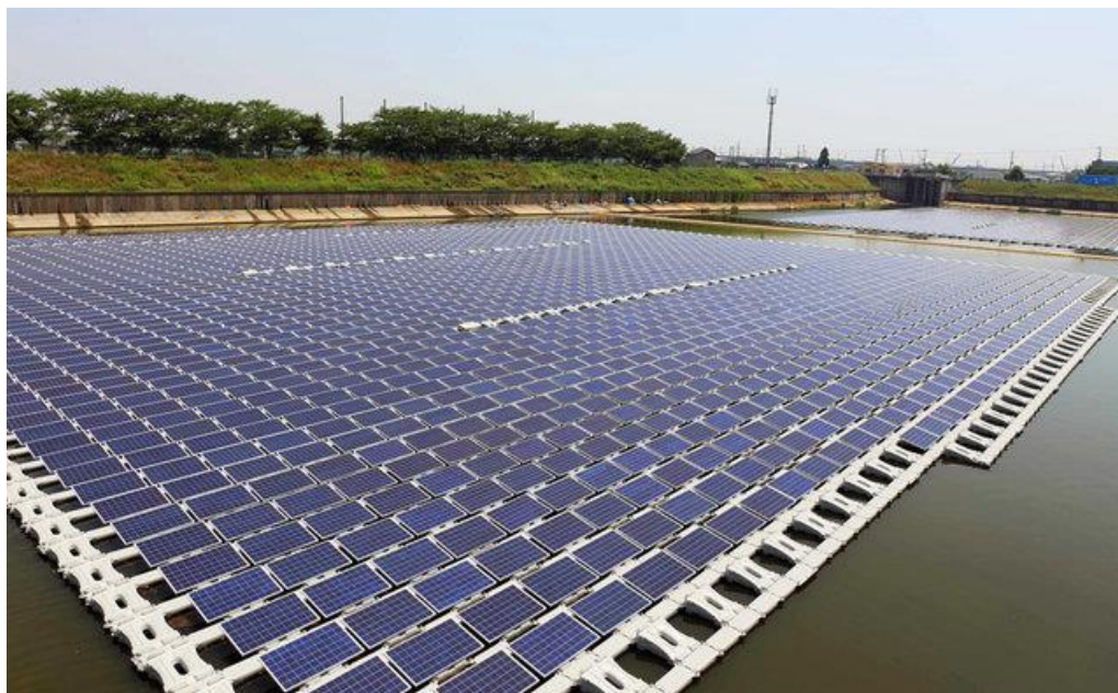
شکل ۱-۵: تصویری از پوشش‌دهی سطح آب حوضچه‌های ذخیره‌سازی آب در هند توسط پنل‌های خورشیدی [۹].
