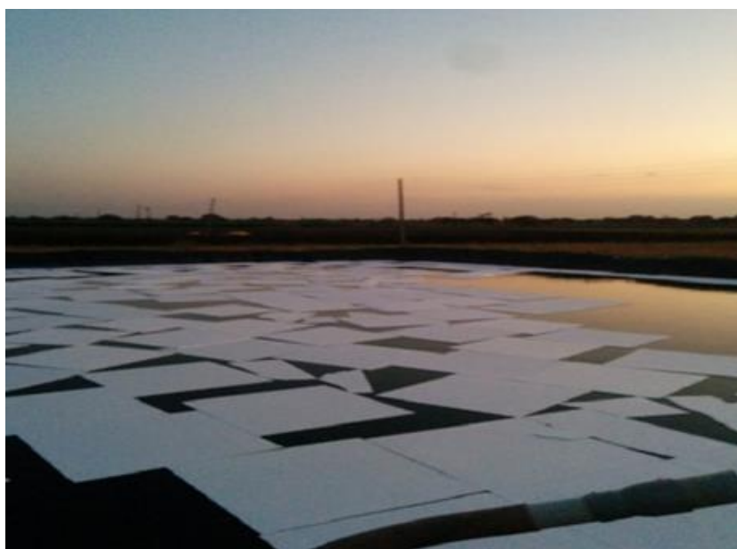
شکل ۱-۷: تصویر پوشش‌دهی سطح حوضچه‌های آب توسط ورقه‌های ترموکل [۹].
