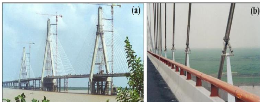
شکل ۱-۳ دمپرهای سیالات مگنتورئولوژیکال نصب‌شده روی پل کابلی [۱۳].
