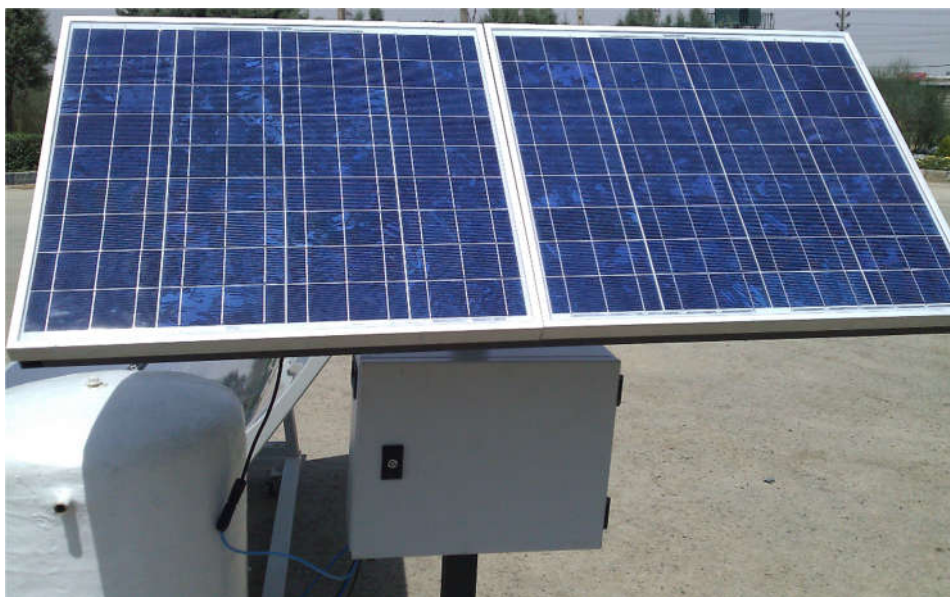
شکل ۳-۸: پنل های فوتولتائیک و محفظه باتری و شارژر
