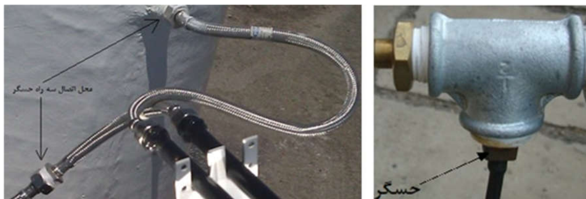
شکل ۳-۱۰: محل اتصال سنسور ها به شلنگ زره دار و مخزن
