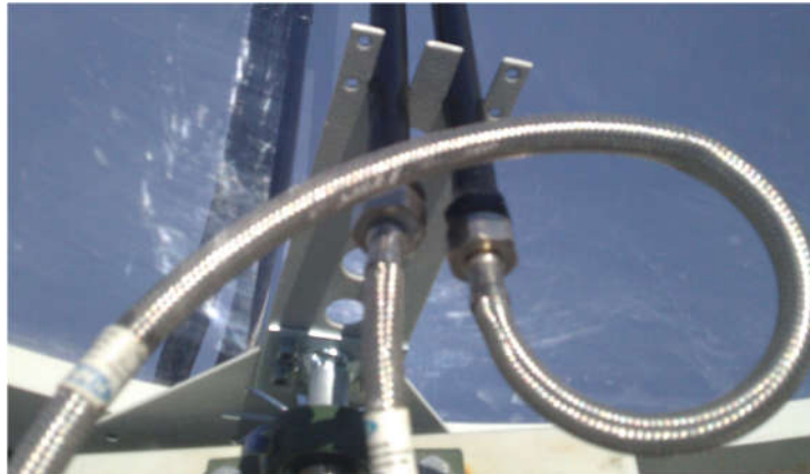
شکل ۳-۹: شلنگ های زره دار و نحوه اتصالات دو سر آن به لوله مسی جاذب
