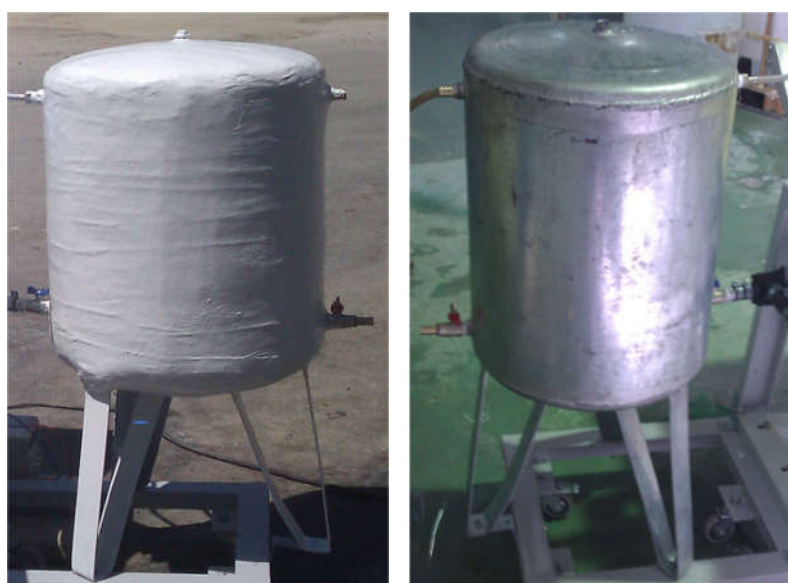
شکل ۳-۱۱: مخزن ذخیره آب قبل (سمت راست) و بعد از عایق بندی (سمت چپ)
