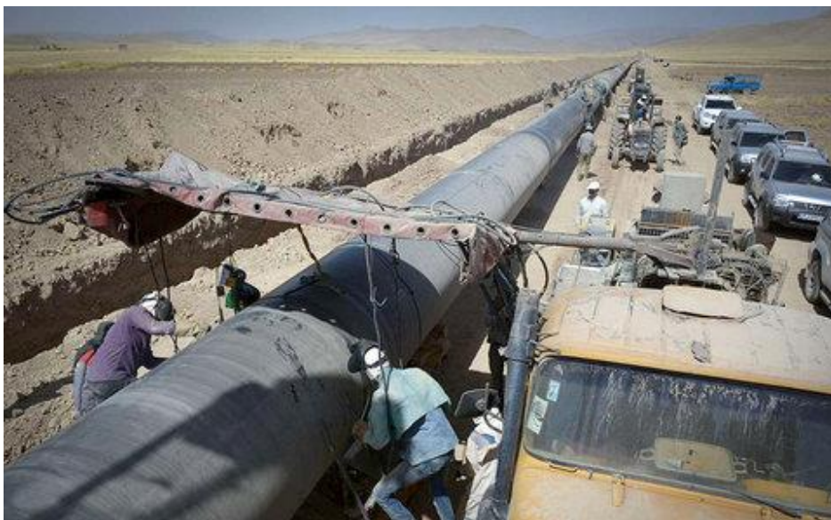
شکل ۲-۲ - خطوط لوله‌ی اصلی انتقال گاز [۷]
