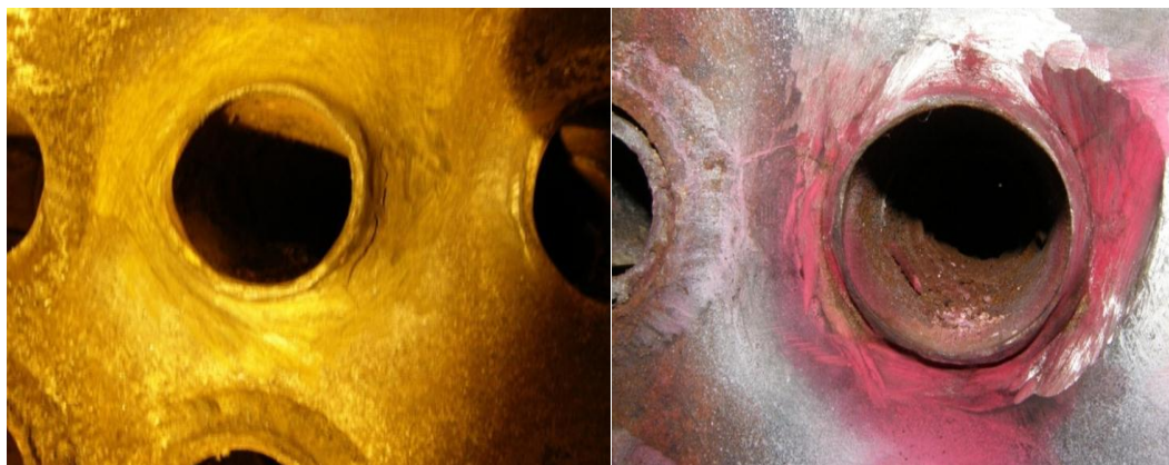
شکل (۲-۲): ترک و نشتی‌های پدید آمده بین تیوب و تیوب شیت [۹]
