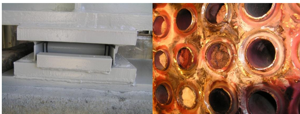
شکل (۶-۲): جوشکاری با الکتروود جدید (DR ۷۰S۶) و تجهیز سدل‌های زیر WHB از لغزشی به غلطشی [۹]
