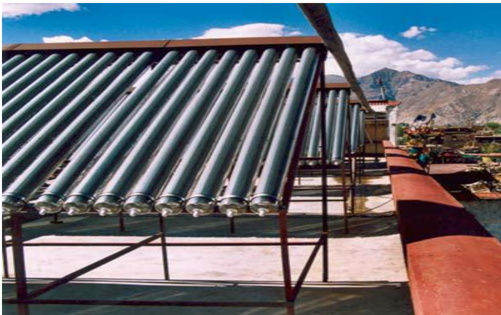
شکل ۱-۱ کلکتور خورشیدی لوله خلا-تبت، چین
