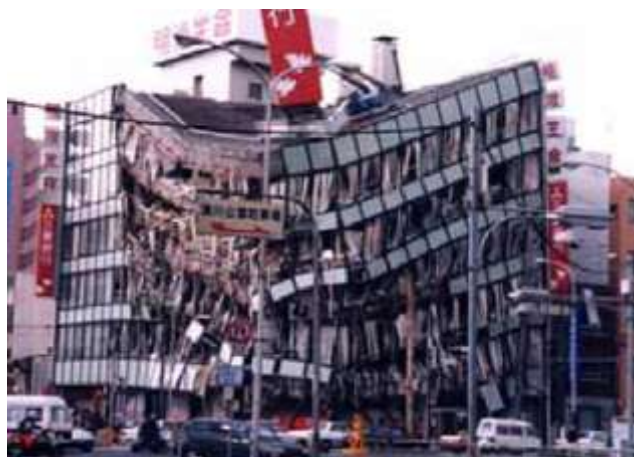
شکل ۱-۶. نمونه ای از خرابی پیشرونده ایجاد شده توسط زلزله [6]
