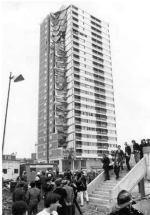
شکل ۱-۱. خرابی پیشرونده در ساختمان رونان پوینت [1]
