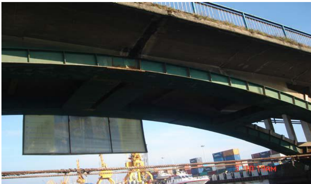
شکل ۲- ۱۸ مقاوم سازی با پیش تنیدگی کابل ها
