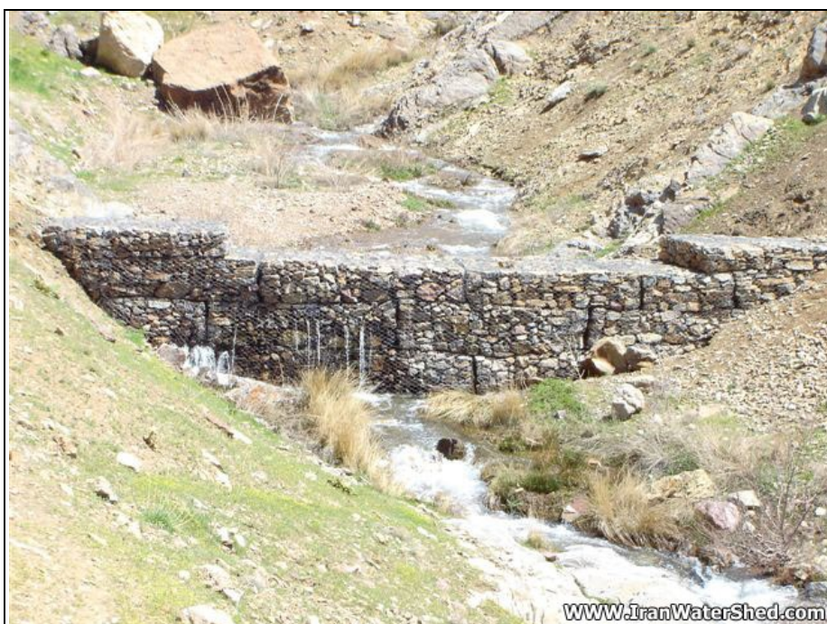
شکل ۳-۳- نمونه ای از چک دم با مصالح سنگی
