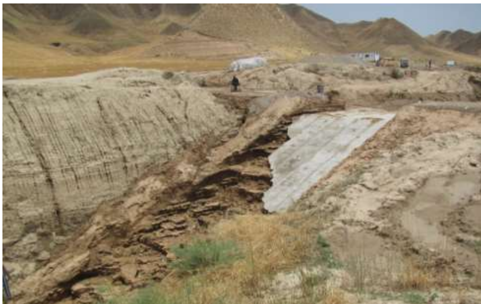
شکل ۱-۱ نمایی از تخریب بند خاکی حوزه آبخیز خیرخواجه به علت استفاده از خاک‌های واگرا
