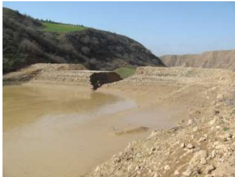
شکل ۲-۱۱ نمایی از وجود آب‌های کدر در بند خاکی روستای قویچق کلاله
