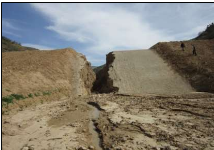
شکل ۲-۱ نمایشی از تخریب بند خاکی حوزه آبخیز قویچق به علت استفاده از خاک‌های واگرا
