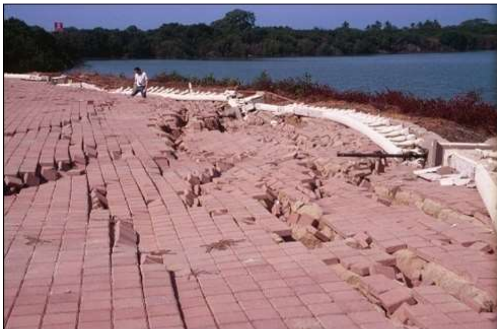
شکل ۴-۲ گسترش جانبی زمین مربوط به زلزله Kocaeli ترکیه ۱۹۹۱ در اثر روانگرایی
