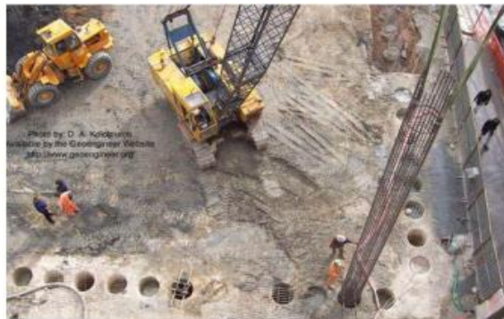
شکل (۲-۵) تصویری از حفاری گمانه‌ها و اجرای شمع بتنی و فولادی
