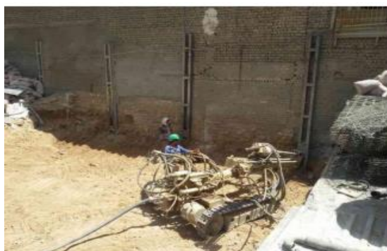
شکل (۲-۵) تصویری از حفاری گمانه‌ها و اجرای شمع بتنی و فولادی
