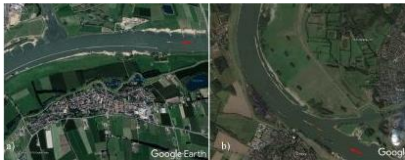
شکل ۲-۱۵: تصویری از رودخانه وال (تصویر سمت راست) و رودخانه راین (تصویر سمت چپ) که در آن‌ها از سیستم دیواره‌های طولی استفاده شده‌است
