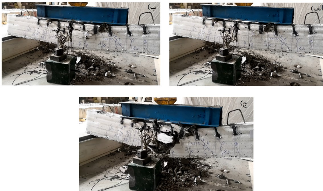
شکل ۴-۳۷ ترک‌های نمونه S.D.20 در لحظات پایانی شکست
