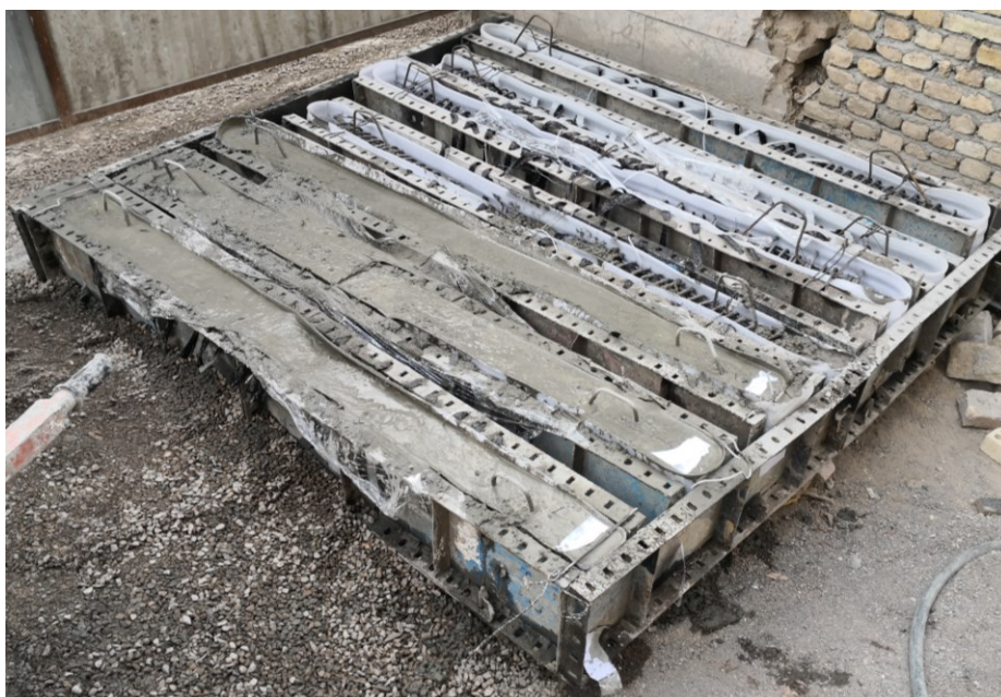
شکل ۴-۱۷ نمونه ها در هنگام بتن ریزی
