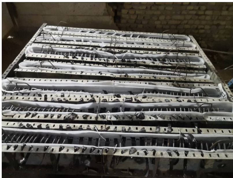
شکل ۴-۱۶ نمونه ها آماده بتن ریزی
