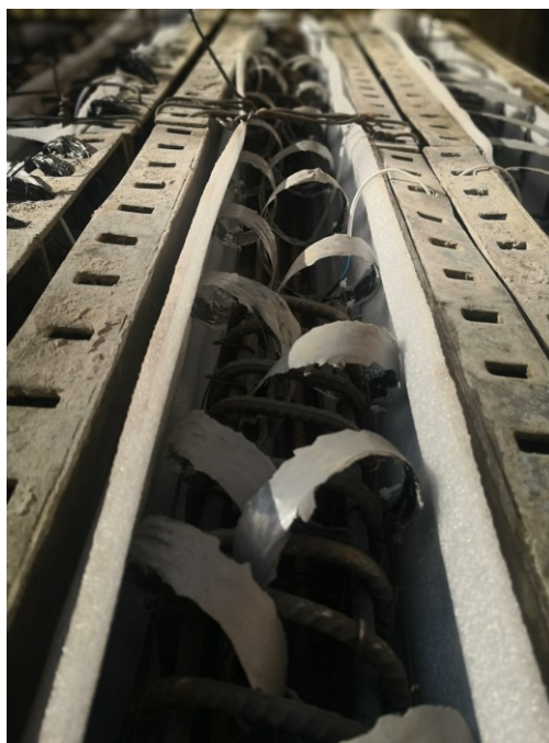
شکل ۴-۱۵ نمونه S.C.pipe آماده ی بتن ریزی
